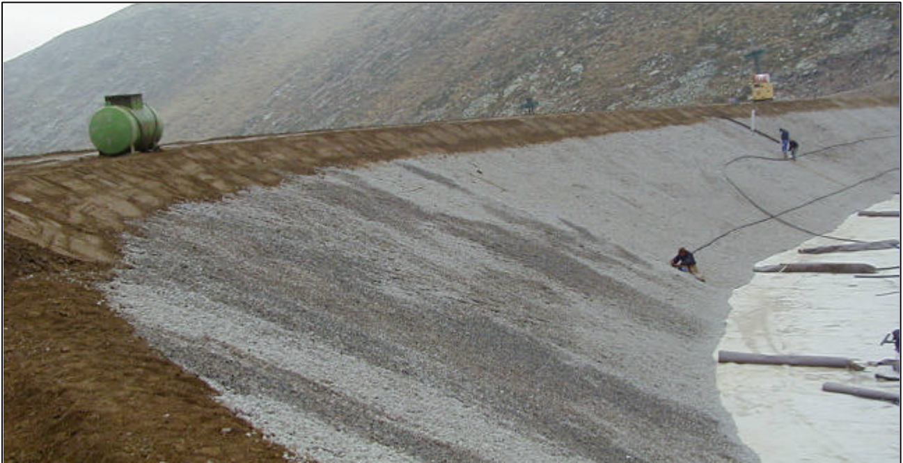
FIGURA 4 – SPONDA DI UN BACINO ARTIFICIALE PROTETTA CON GEOCELLE RIEMPITE DI GHIAIA
