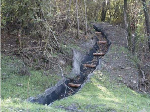
Il geocomposito TRENCHMAT S di peso complessivo 1100 gr/mq, viene posato ed ancorato mediante l'utilizzo di picchetti in tondino ad aderenza migliorata piegati a manico d'ombrello di diametro mm 8 e lunghezza minima cm 30 in ragione di n° 4 picchetti a ml. di cui due sul fondo ed uno per ciascun lato in sommità, avendo cura di ripiegare il geocomposito in sommità per una larghezza di 10 cm verso l'esterno, ricoprendolo di terreno per un migliore ancoraggio del sistema.
