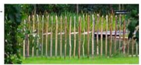
I paletti sono legati con filo galvanizzato con diametro di 1.8 mm (95% Zinco e 5% alluminio) resistente agli agenti atmosferici e testato anche in ambiente marino (sulle spiaggie).
