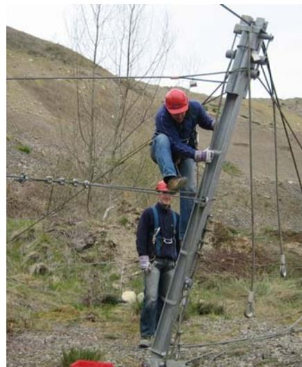
Figura 28 Fune di sospensione tra i montanti per installare la rete
