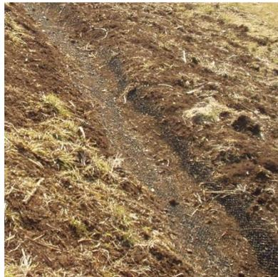
**3** Reinterrare i lati e saturare con terreno fine tutta la superficie della canaletta al fine di garantire una buona protezione ai raggi UV. Eventualmente fissare con tondame di legno in prossimità dell'ammorsamento laterale al fine di rendere più stabile la zona a bordo dello scavo
