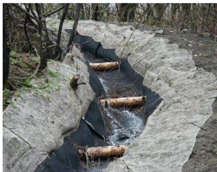
**4** Si consiglia di abbinare una biostuoia biodegradabile sui lati della canaletta, al fine di contenere i fenomeni erosivi, prima della crescita della vegetazione. Per applicazioni su forti pendenze, inserire longitudinalmente i tronchi rompi-tratta per ridurre le velocità dell'acqua e ricordarsi di predisporre adeguate opere di raccolta, a valle.
