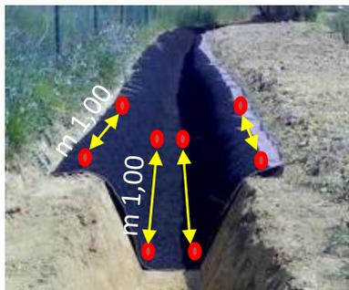
**1** Eseguire uno scavo di sezione vendendo cura di lasciare 10 cm di canaletta per parte da ammassare con successivo reinterro e ancorare la canaletta al suolo mediante n° 4/8 (altezza m 1,00 e m 2,00) picchetti ● in ferro di diam mm 8 e lunghezza adeguata (min. 25 cm)
