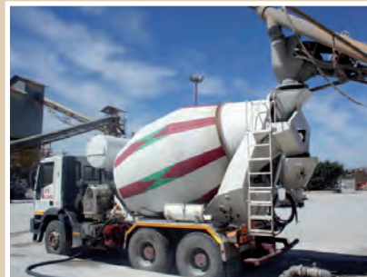
Pre-miscelazione in impianto del 70% di Soil Sement® indicato, diluito in acqua, con l'inerte selezionato come da curva granulometrica indicata.
