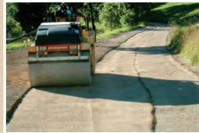
Compattare con rullo di peso adeguato
