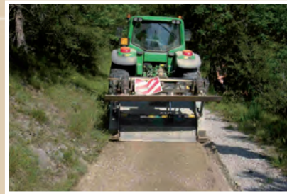
Fresare la pavimentazione esistente dopo aver costipato eventuali avvallamenti
