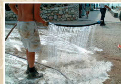
5. Bagnatura finale con 30% di Soil Sement rimanente diluito in acqua
