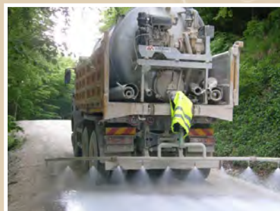
Irrorare la superficie con il 30% del Soil Sement® rimanente diluito in acqua
