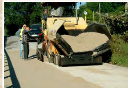
Stesura della miscela a mezzo vibro finitrice con piastre fredde e vibranti
