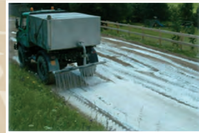
Irrorare la superficie con il 70% di Soil Sement® indicato, diluito in acqua
