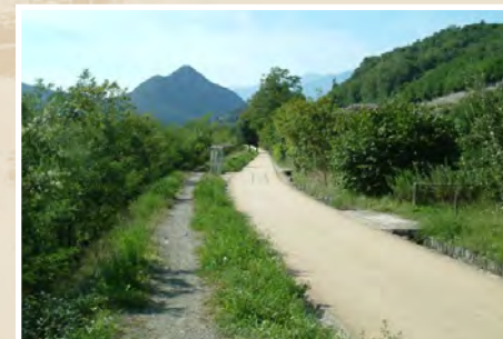
Pavimentazione ecologica carrabile al termine dei lavori
