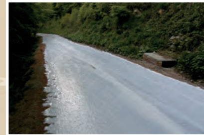
Irrorare la superficie con il 30% di Soil Sement® rimanente, diluito in acqua.
