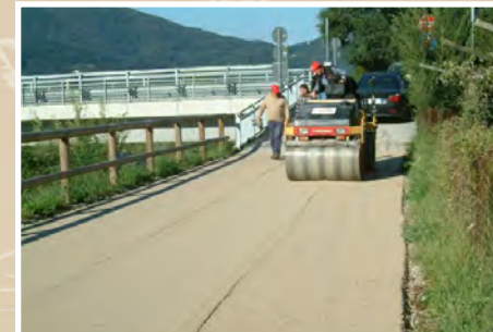
Compattazione con rullo di peso adeguato
