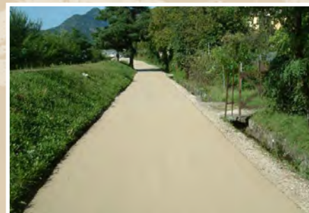
Pavimentazione ecologica carrabile al termine dei lavori
