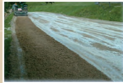
Miscelare con fresa o interrasassi per una corretta amalgama
