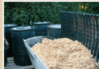
1. Premiscelazione in benna con 70% di Soil Sement diluito in acqua
