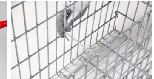
Place the 2 rods inside to avoid any deformation of the gabion. Platzieren Sie die zwei Stangen im Inneren, um Verformungen der Gabionen zu vermeiden.
