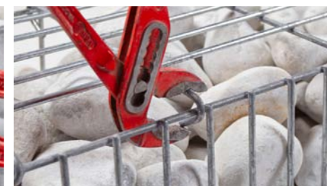
Ziehen Sie die Haken mit einer Zange an.
