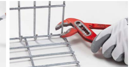
Close all corners with a pair of pliers. Schließen Sie die Ecken mit einer Zange.
