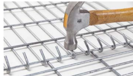
Per velocizzare la successiva operazione di chiusura dei ganci, si può utilizzare un martello. Pour accélérer l'opération de fermeture des crochets, vous pouvez utiliser un marteau.
