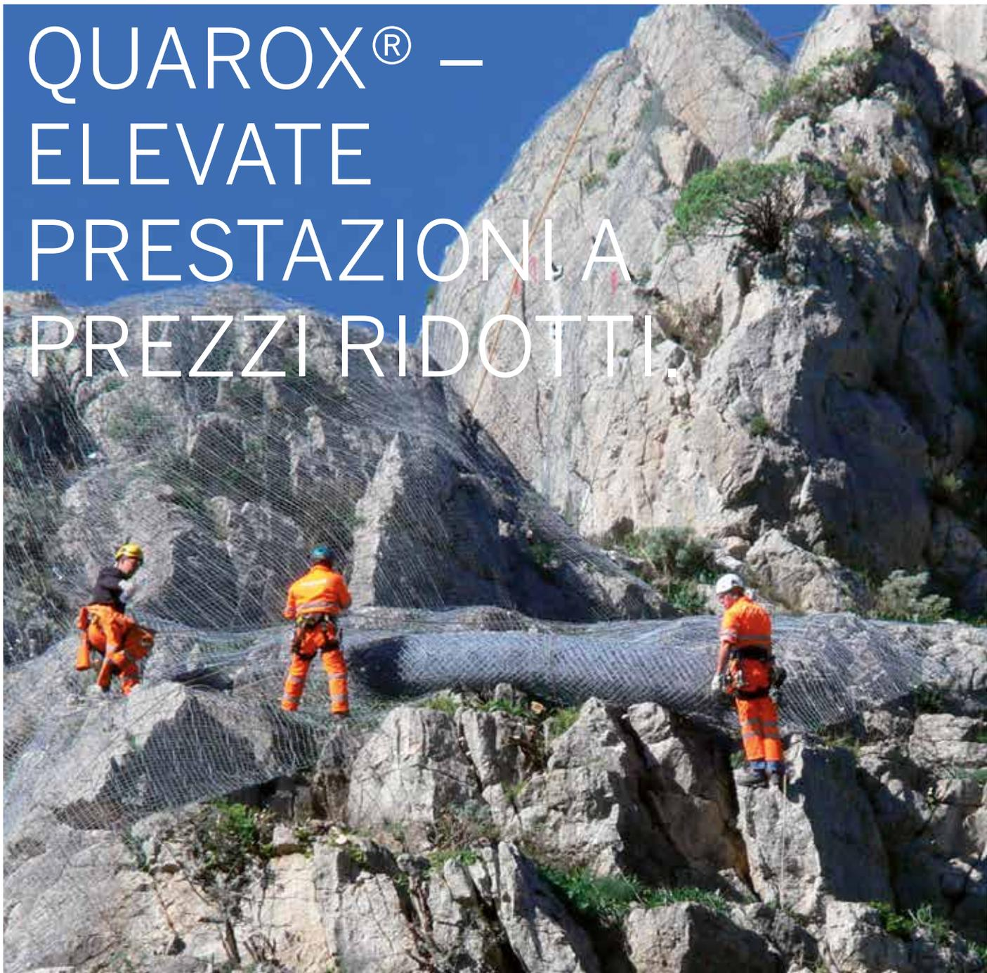
La rete in fune spiroidale QUAROX®, in rotoli, permette una adattabile e ben distribuita trasmissione dei carichi, fornendo quindi una stabilità senza pari. Questa rete è diversa dalle tradizionali reti di filo, prodotte utilizzando borchie o funi di legatura, la cui struttura a maglie tende ad allentarsi molto facilmente in caso di stress meccanico localizzato, come avviene per la caduta massi.
