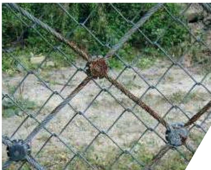
Con le normali reti a filo in rotoli, le borchie causano spesso l'usura prematura della protezione anticorrosione dovuta a un ristagno di umidità e/o la combinazione di vari metalli. Inoltre, una fascetta di connessione potrebbe spostarsi in occasione della caduta di un masso, creando un punto di debolezza.
