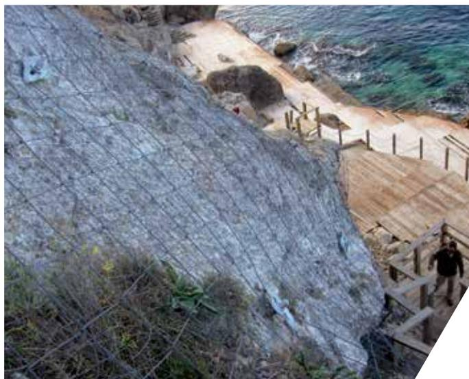
Grazie alla sua struttura di connessione a maglie mobili, QUAROX® si adatta in maniera ottimale anche a terreni irregolari.
