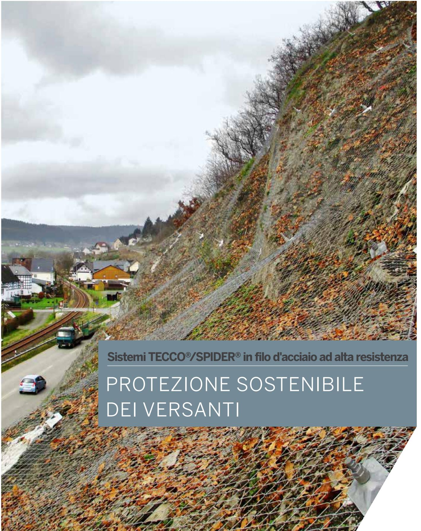
Sistemi TECCO®/SPIDER® in filo d'acciaio ad alta resistenza
