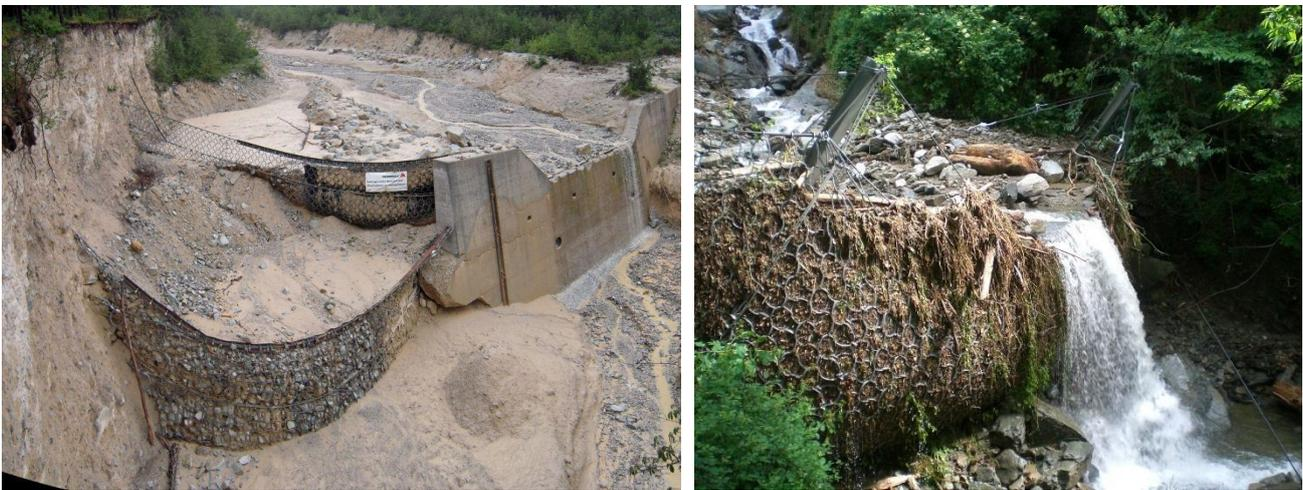
*Figura 1: Applicazione di barriere in rete ad anelli come costruzione aggiuntiva ad una diga di controllo in calcestruzzo nell'Ilgraben nel Canton Vallese in Svizzera (a sinistra) e una barriera in rete ad anelli riempita con successo in Italia (a destra).*
