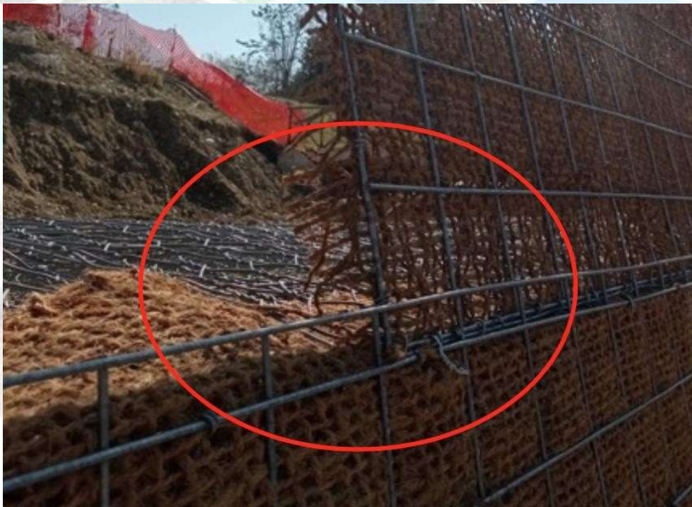
Foto 10 – Dettaglio del “dente” di appoggio.
