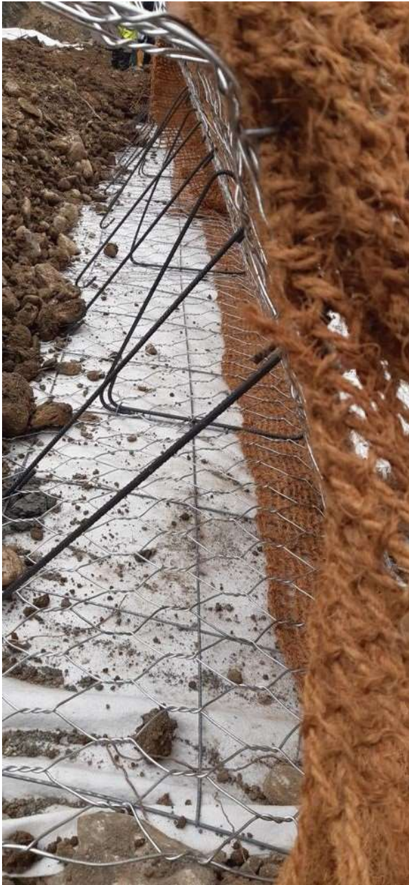
Foto 3 - Apertura e posizionamento staffe e tiranti (vista laterale).
