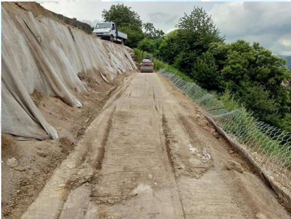
Foto 8 - Compattazione del terreno di riempimento con rullo compressore.
