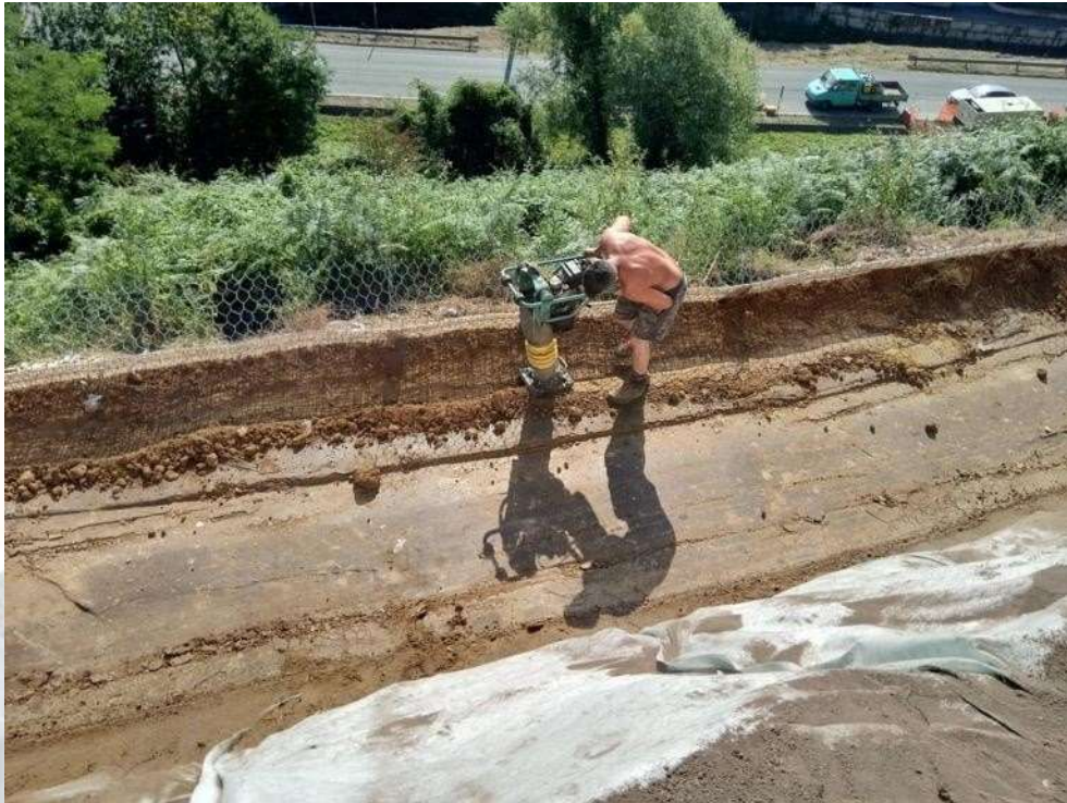
Foto 9 - Compattazione del terreno vegetale frontale con piastra vibrante.
