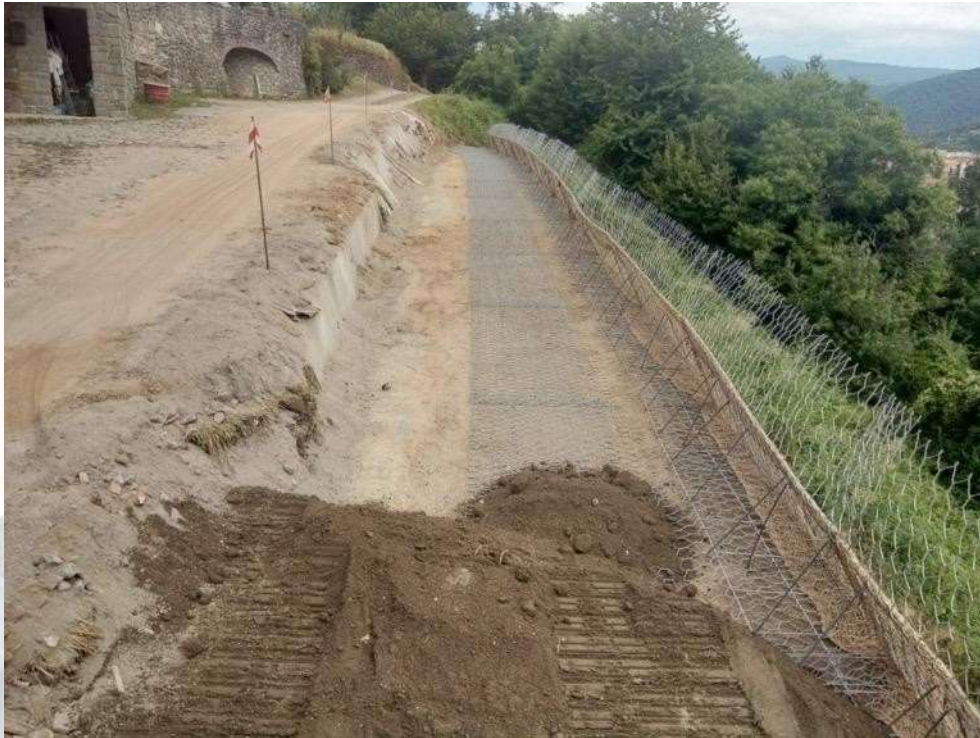
Foto 7 - Posa dello strato di terreno vegetale.
