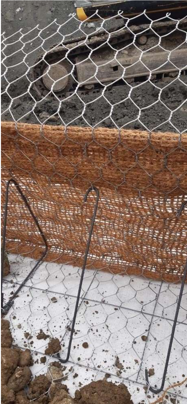
Foto 2 - Apertura e posizionamento delle staffe e dei tiranti (vista da tergo).
