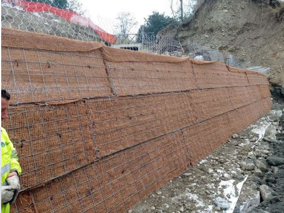
Foto 11 – Esempio di posa errata: i ricorsi sono stati posati senza rispettare il “dente” di appoggio.
