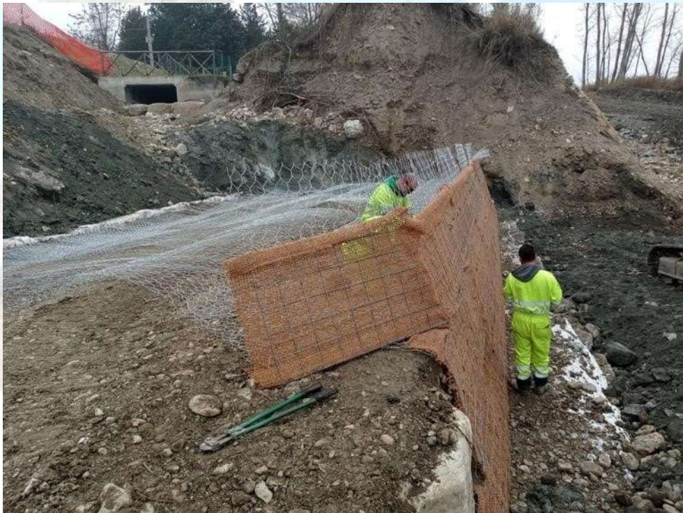
Foto 12 – Esempio di posa errata: i ricorsi sono stati posati senza rispettare il “dente” di appoggio.
