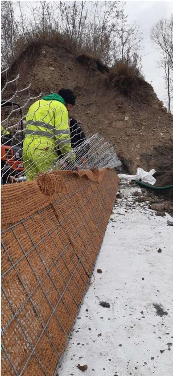
Foto 1 - Apertura ed allineamento dei moduli ArrTerr (vista laterale).
