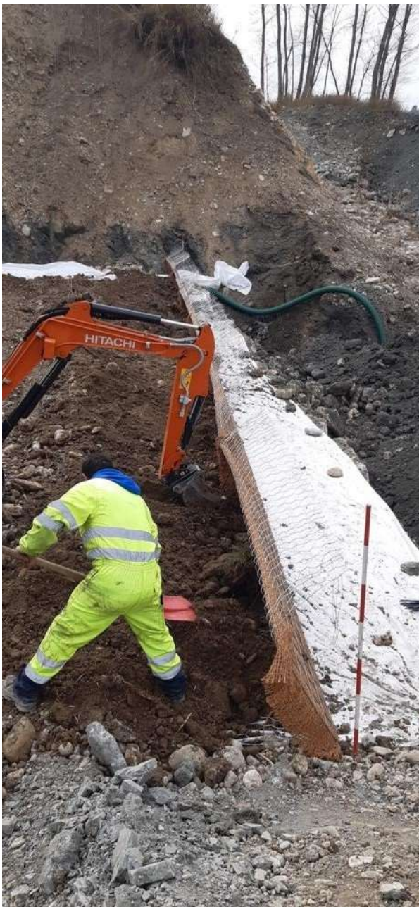
Foto 6 - Posa dello strato di terreno vegetale per circa 20-30cm internamente a ridosso del ritentore di fino e compattazione a bennetta e badile.
