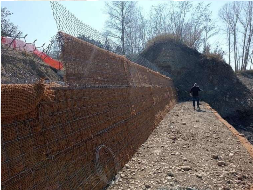
Foto 14 – Confronto tra posa corretta (ricorso superiore) e posa non corretta (ricorso inferiore).
