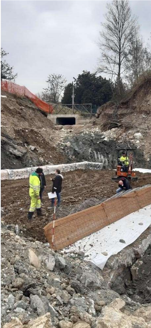
Foto 4 - Apertura ed allineamento dei moduli ArrTerr, vista frontale. Si noti, al contatto fra il termine delle code di rinforzo e la base del versante, il drenaggio realizzato con pannelli Drenar.
