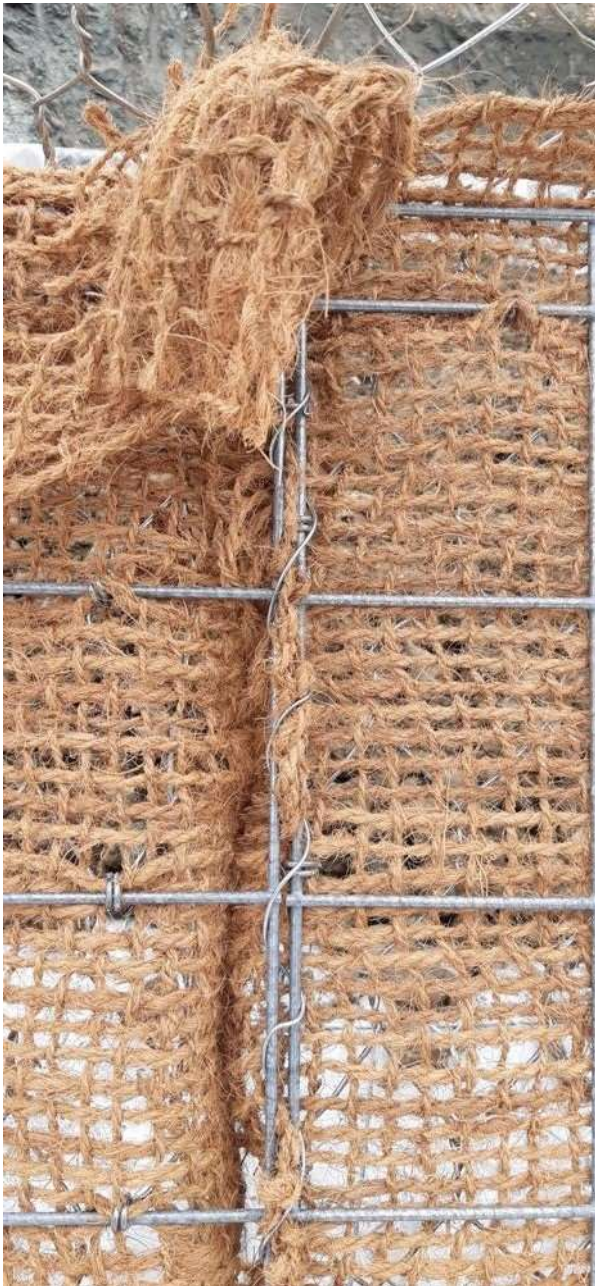
Foto 5 - Dettaglio legatura fra moduli con filo in continuo.
