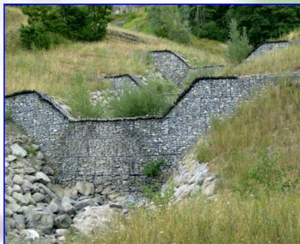
*Foto 3 – Serie di briglie trasversali in gabbioni sul torrente Guadarolo – Ligonchio (RE). Si noti la protezione della gaveta con rivestimento in tondo di legname.*
