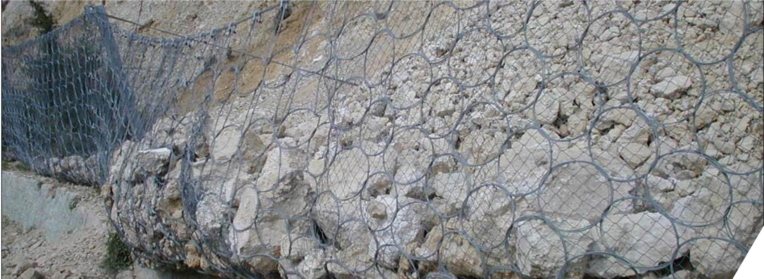
Particolare di un impatto in una barriera con campata singola / MEF\*
