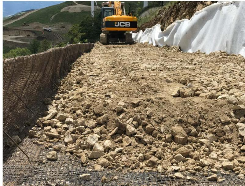
**TERRE RINFORZATE: FASI DI INSTALLAZIONE DEL PAVIDRAIN**
