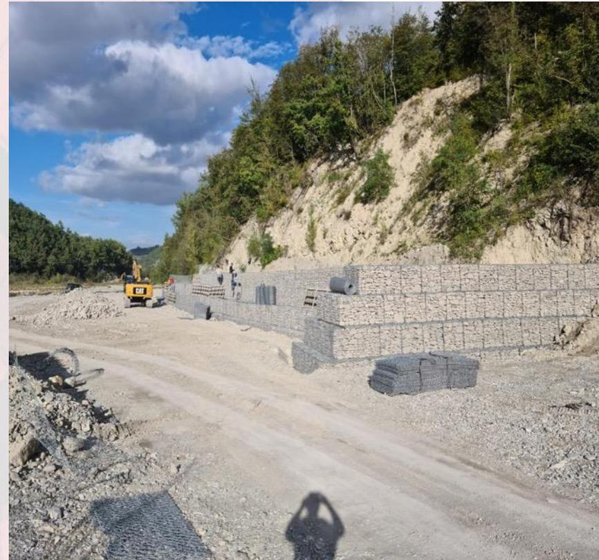
*Messa in sicurezza idraulica con pennelli – foto dx Torrente Baganza, loc. Castellaro di Sala Baganza (PR)*
