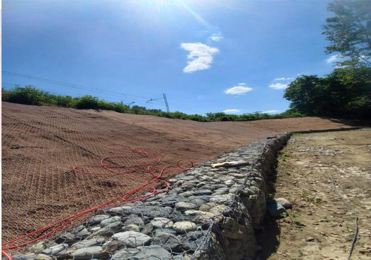
*Messa in sicurezza idraulica e versante massicciata ferroviaria con tecniche miste (gabbioni, materassi, geocompositi Arco)*
