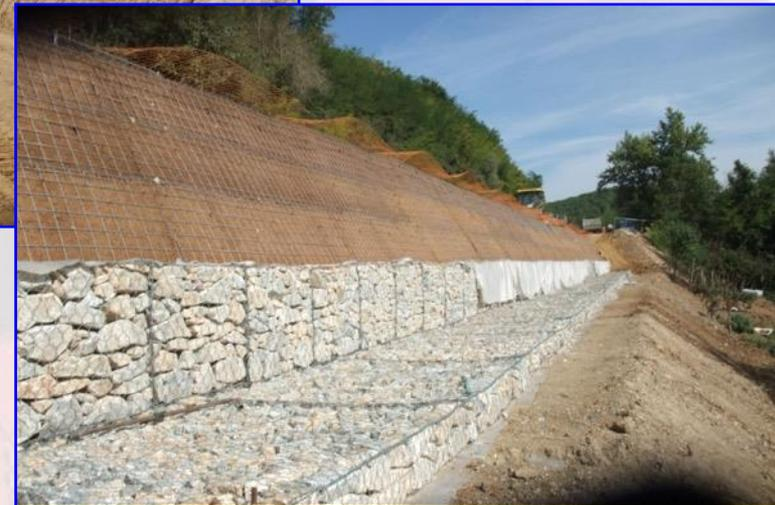
Rilevati misti in terre rinforzate preassemblate ArrTerr e gabbioni – Ponte alle Armi (SI):
