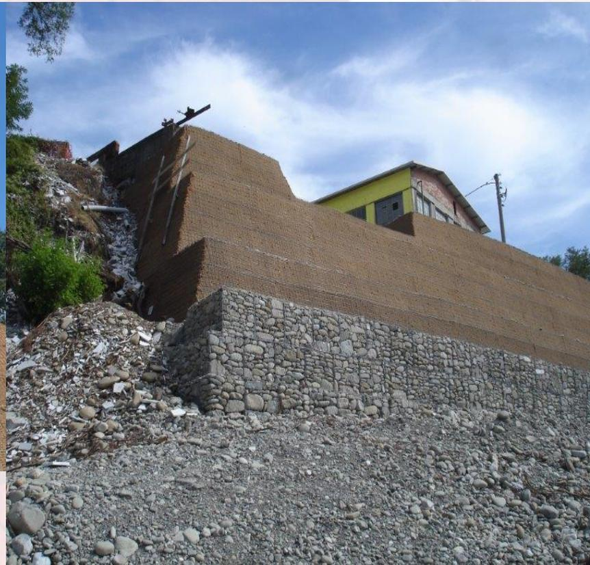
Rilevati in terre rinforzate preassemblate ArrTerr: consolidamenti sottoscarpa
