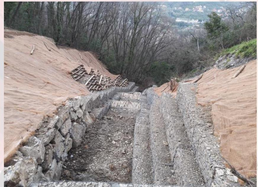
*Messa in sicurezza idraulica e versanti con tecniche miste (gabbioni, materassi, geocompositi Arco, scogliere, palificate doppia e briglia selettiva) – Comune di Genova – Rivi Via Montelungo, zona Struppa*
