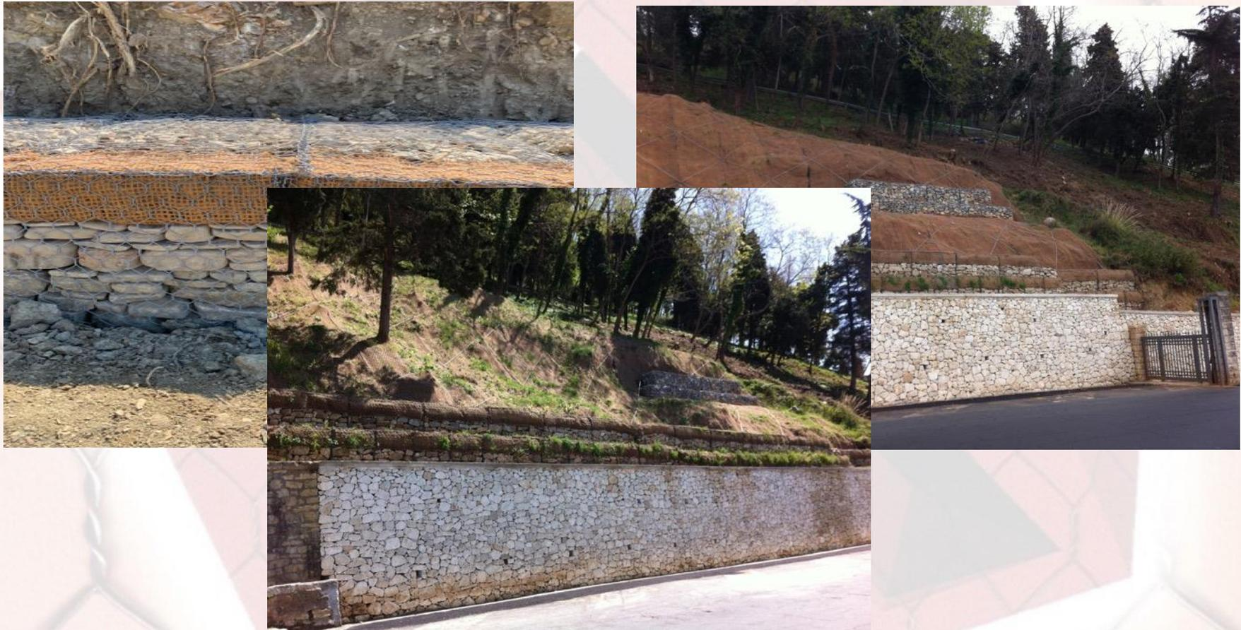
Messa in sicurezza versante in controripa stradale, in area vincolata, con utilizzo di Gabbioni Verdi, Geocompositi rete+cocco (Arco), gabbionate e muro rivestito in pietrame
