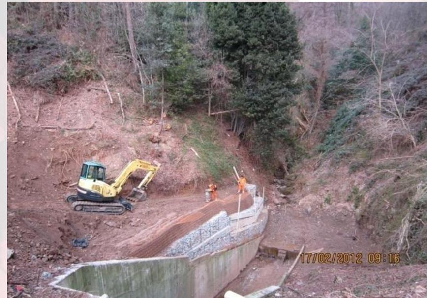
Sistemazione alveo e versante Rio Marotto – Sestri Ponente Genova; tecniche combinate a basso impatto: gabbioni, terre rinforzate preassemblate ArrTerr, e pannelli drenanti Drenar
