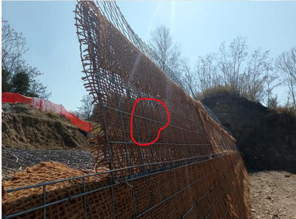
Rilevato arginale combinato terre rinforzate ArrTerr con nuovo dente di sicurezza per sormonto e trincea drenante prefabbricata a tergo
