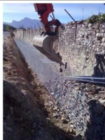
Esempio configurazione pannelli per gabbione m 2,00x1,00x1,00
